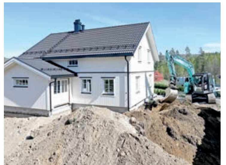
UTVENDING ARBEID: Grunnmurane blir drenert rundt og isolert, og massar fylt tilbake. Her er folk frå Groven og Karlsen i sving.
