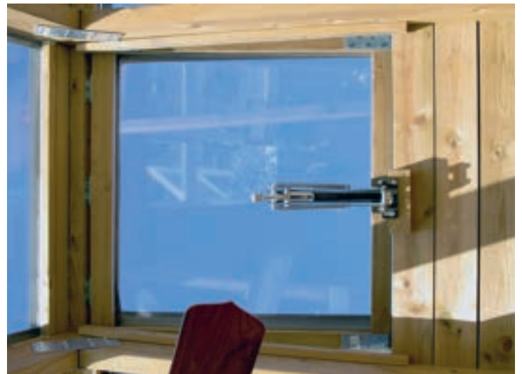
AUTOMATISK LUFTING: Når det blir for varmt opnar vindauget seg automatisk.
