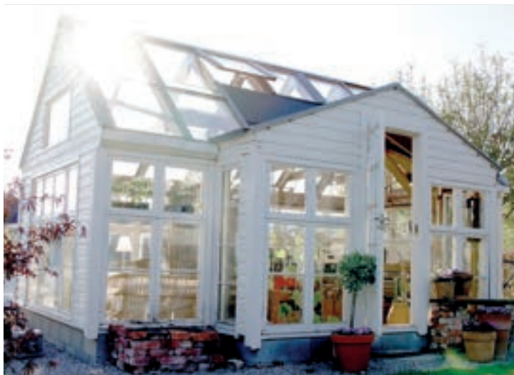
STOVE OG DRIVHUS: Det som starta som eit drivhus har også blitt til uestove.
