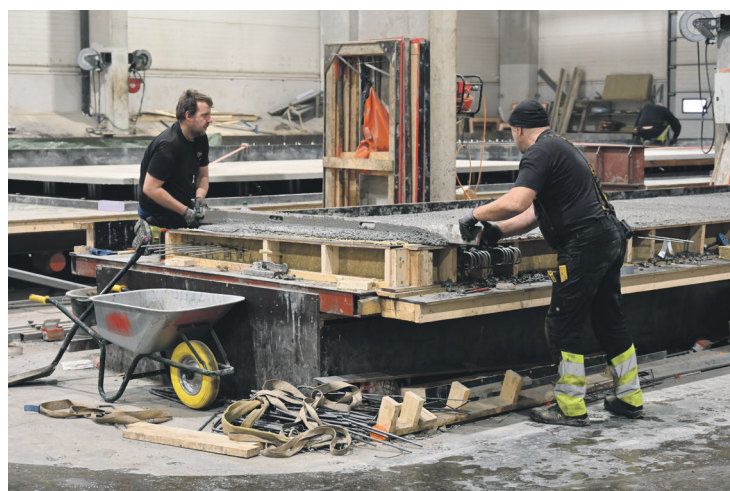
VEGGELEMENT: Flest folk er det i arbeid på avdelinga som lagar veggelement av ulike slag. Dette er Dawid Maciaszek og Artur Kurkchi.
