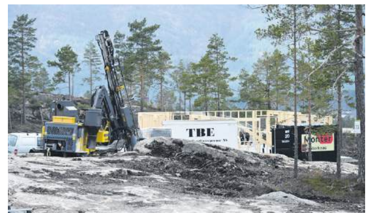
FLEIRE PROSJEKT: Her er Telemark byggentreprenør i sving på ei anna tomt i Nordbøbergja.
