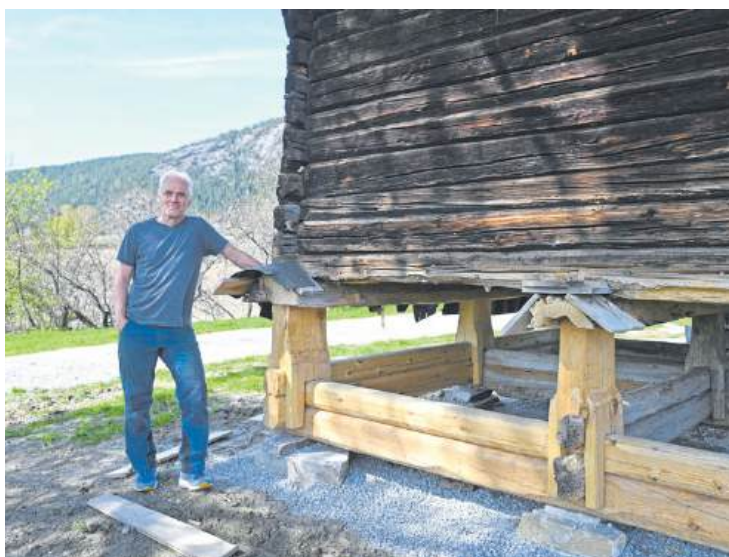
RESTAURERINGSARBEID: Heile stabburet er heisa opp og understellet bytta ut.
