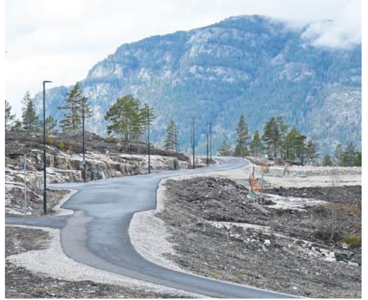
NYTT BYGGEFELT: Bustadfeltet er bygd ut med all infrastruktur på plass. FOTO: Øystein Akselberg
