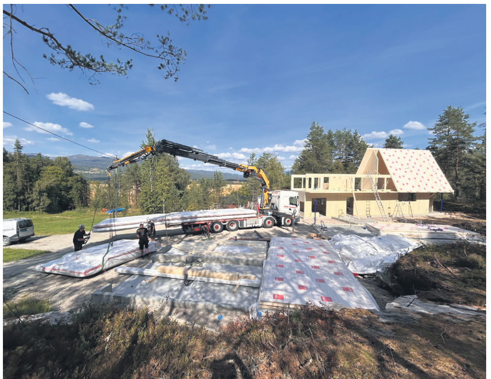
NISTÅS: Massivtrehus under oppføring av selskapet Massivtre AS. Arkitekt er Olav Lunde Arneberg i selskapet Gartnerfuglen Arkitekter.
